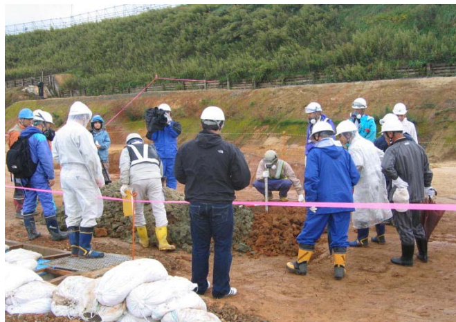
地山確認の様子
