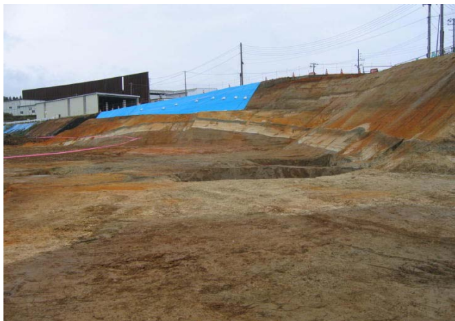
地山確認エリア（北東側）
