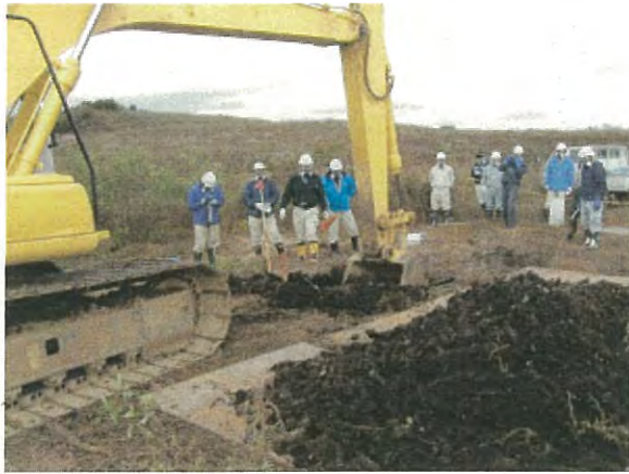
写真 1 重機掘削状況
