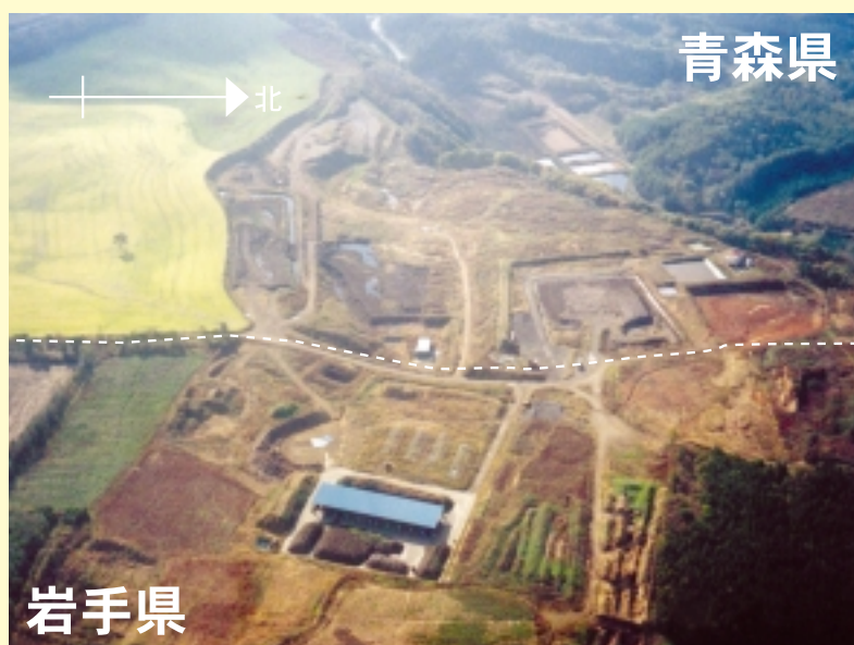
平成12年10月当時の現場全景
