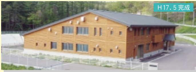
浸出水処理施設
