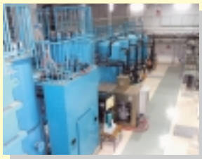
浸出水処理施設内部
