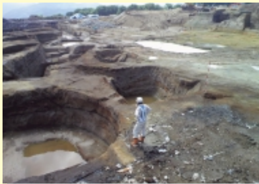
廃棄物の撤去を進めていくうちに、元々の地面の一部に穴を掘り廃棄物が捨てられていたことがわかりました。
