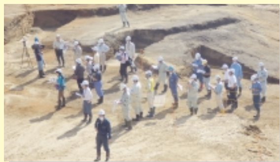
第12回地山確認（地山表層）
