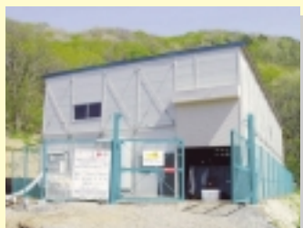
仮設浄化プラント (H17.7 撤去)
