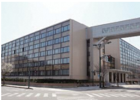
耐震・長寿命化改修工事が終了しました。
