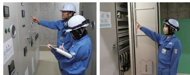
日常巡視点検。指さし確認は忘れずに。
