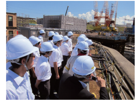
見学(電源開発(株)大間原子力建設所)
