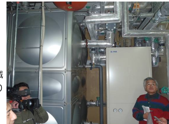
登府屋旅館機械室 左：貯水タンク、右：ヒートポンプ
