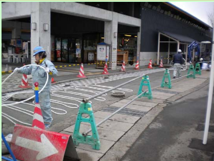
放熱管敷設状況
