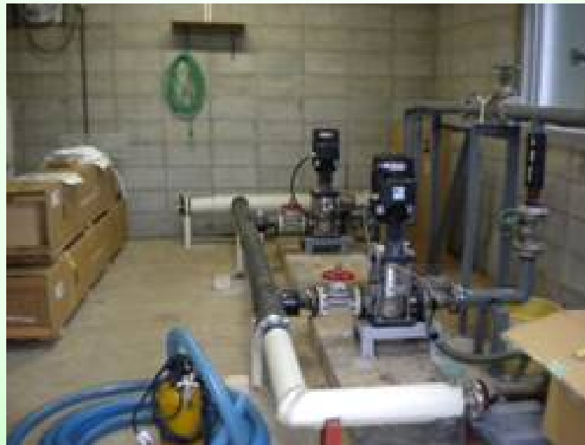
菟頭配湯所（ポンプ室）
