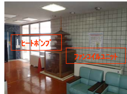
ヒートポンプとファンコイルユニット
