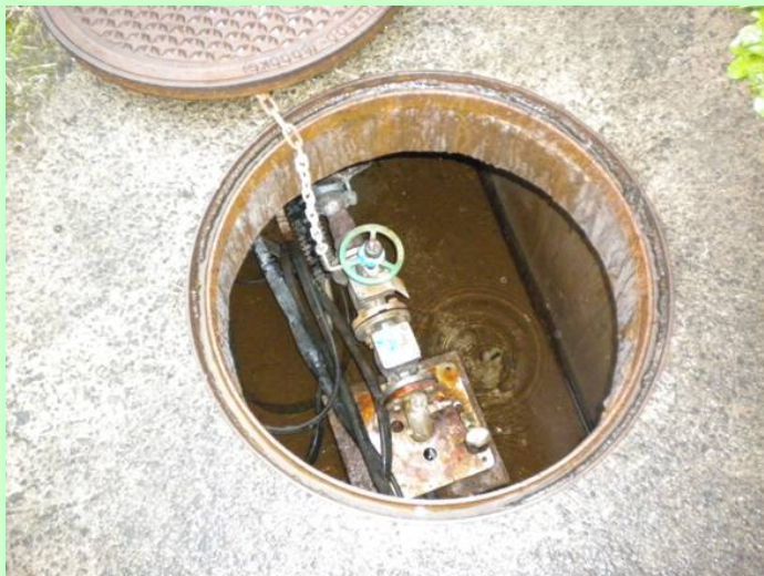
菟頭源泉 坑口ピット
