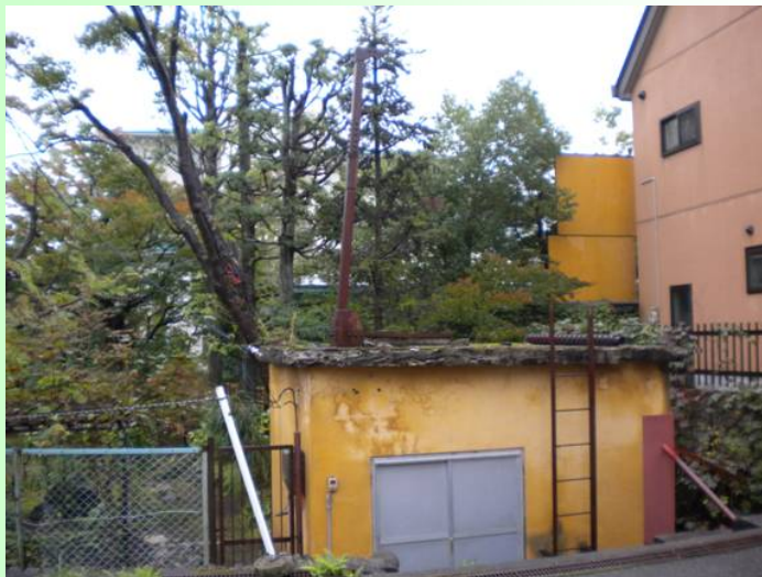
石原源泉機械室外観
