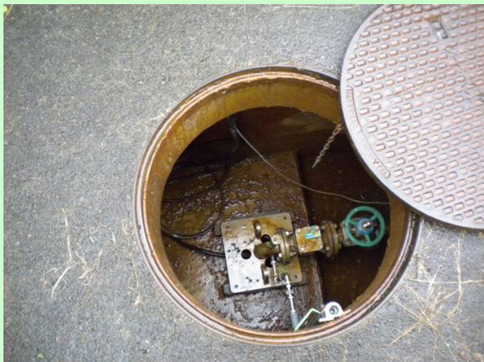
赤湯源泉 坑口ピット
